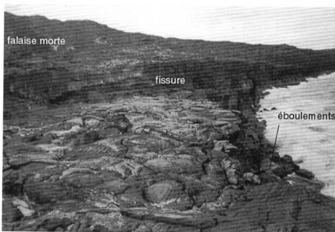
Photo 1 : Banquette effondrée en marge du delta de Lae'apuki
