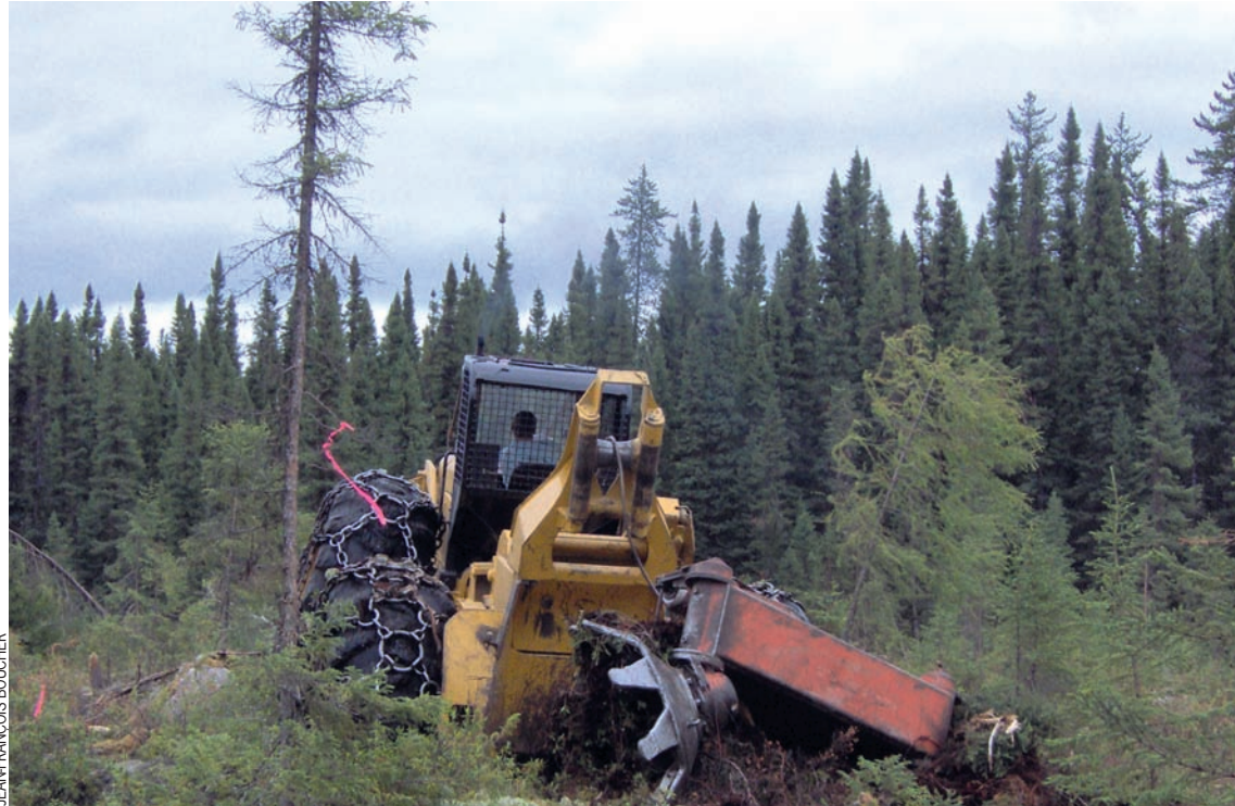
Scarifiage du sol. L'opération permet de créer des sillons où des plants seront mis en terre.
