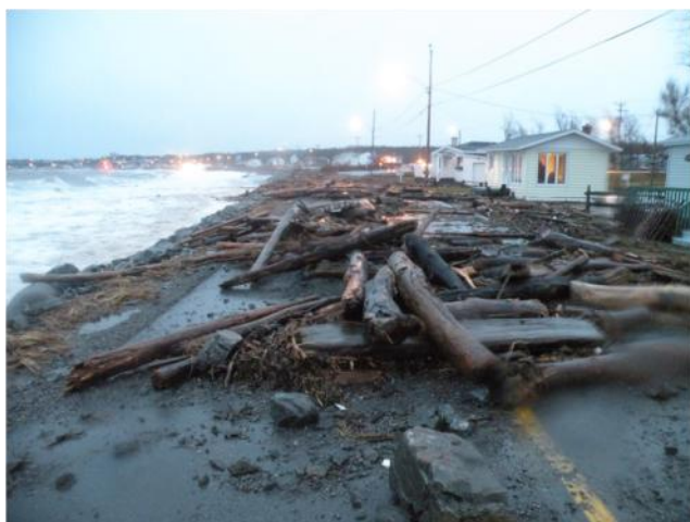
Débris de tempête sur la Route du Fleuve, après la tempête du 6 décembre 2010.
