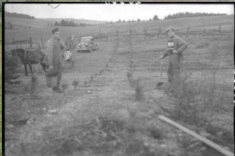
Reboisement à Vallée-Jonction, comté de Beauce / Alp. Guimont – 1945, COTE : E6,S7,SS1,P25888, Centre d'archives de Québec, BANQ.
