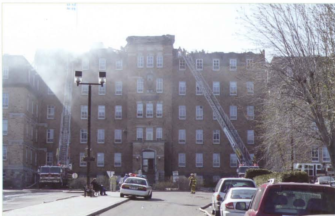
L'incendie sur le toit de l'aile centrale de l'UQAR, en mai 2009, a causé un choc dans toute la communauté.
