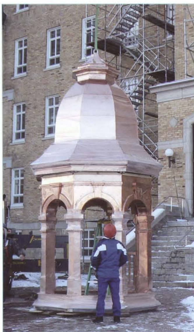
Les travaux d'installation de la cloche et du clocheton sur le toit de l'UQAR, en décembre 2009, sont venus clore les rénovations.
