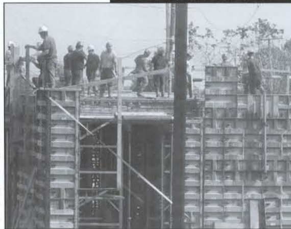
Le CAIR, en pleine construction.
