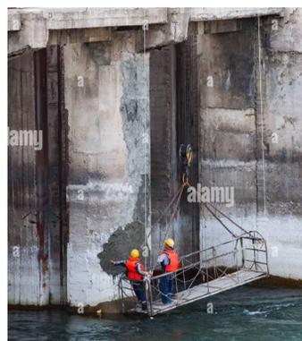
FIGURE 1 – Inspection d'un barrage par intervention humaine.
