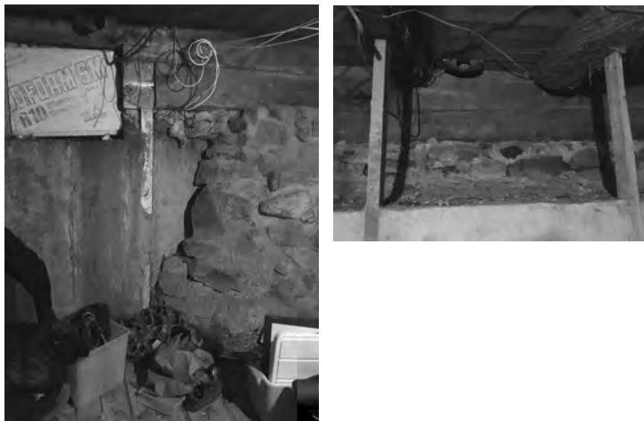
Figure 2. a. Fondation du mur est dans le sous-sol. En pierre à l'intérieur et béton à l'extérieur (Laurence Des Lauriers-Chouinard). b. Fondation du mur nord dans le sous-sol. En béton à l'intérieur et pierre à l'extérieur. On aperçoit également la structure en pièce sur pièce (Laurence Des Lauriers-Chouinard).
